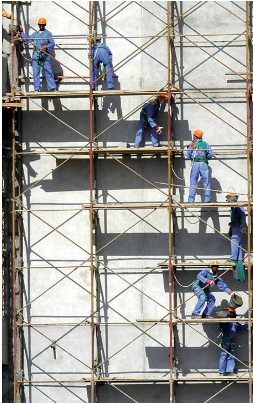
Baustellen begründen eine Betriebsstätte im Sinne des KommStG, wenn die Bauausführungen voraussichtlich länger als sechs Monate dauern.
