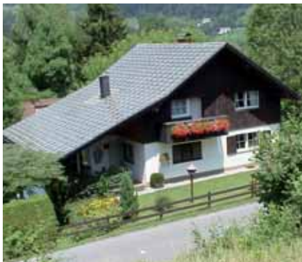
Die Photovoltaik-Anlagen passen formschön aufs Dach.
