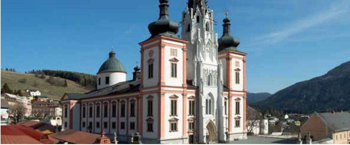
Die Basilika Mariazell wurde in den letzten Jahren vollständig saniert.
