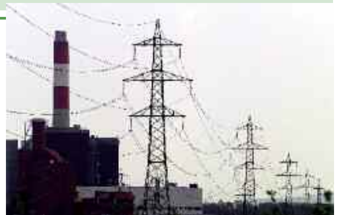
Ein neues Gaskraftwerk sorgt für Zwiespalt in Klagenfurt
