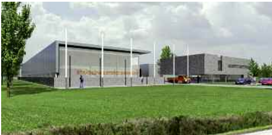
Die neue Straßenmeisterei in Sierndorf setzt mit modernster Ausstattung und energieeffizienter Bauweise neue Maßstäbe.
