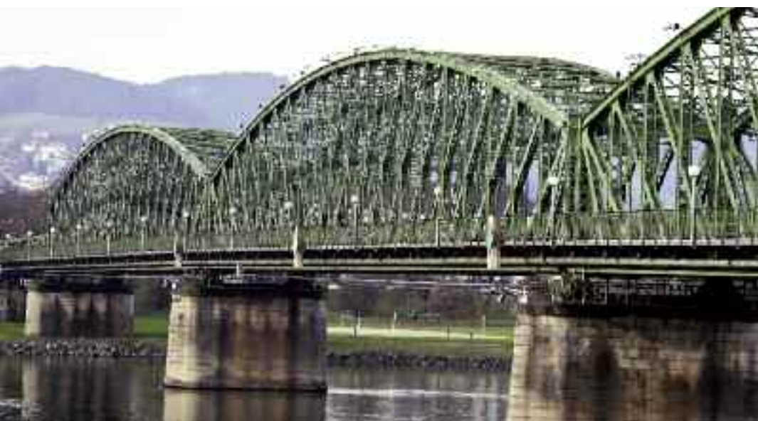
Schaut massiv aus, aber im Ernstfall gilt es auch diese Donau-Eisenbahnbrücke in Linz zu sichern; das Projekt DESTRail will ein automatisches Zugstoppsystem für den Gefahrenfall etablieren.
