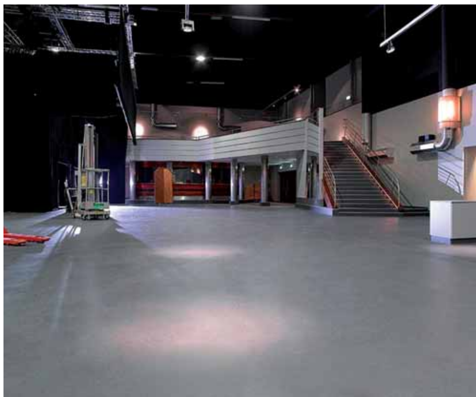
Die Oberfläche dieses Kautschukbelags von nora wurde abgestimmt auf die in der Veranstaltungshalle ständig wechselnden Belastungen.
