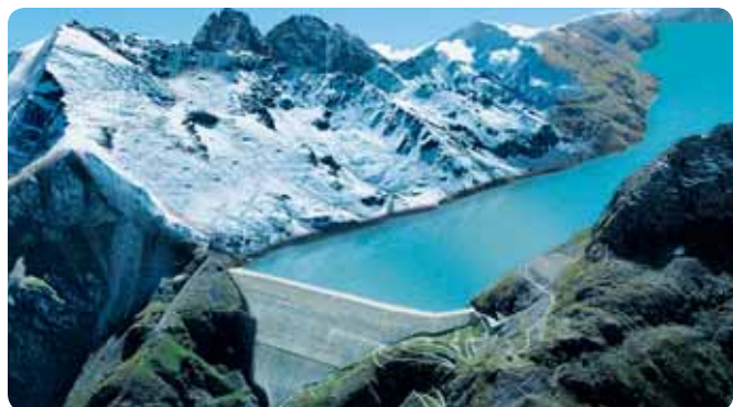
WASSERKRAFT als sauberer Stromlieferant
