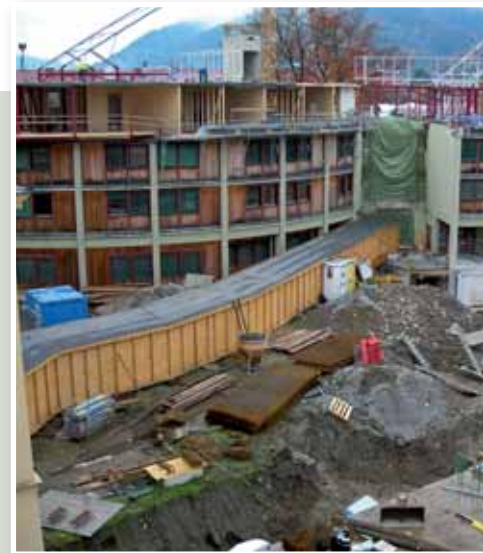
Bei den Abbrucharbeiten wurde auf eine optimale Wiederverwertung und fachgerechte Baumassentrennung geachtet.
