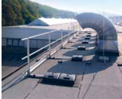
Dacharbeiten sind gefährlich. Sicherheit ist daher oberstes Gebot.
