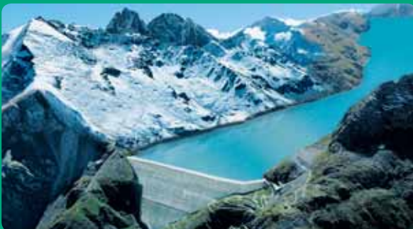
WASSERKRAFT als sauberer Stromlieferant
