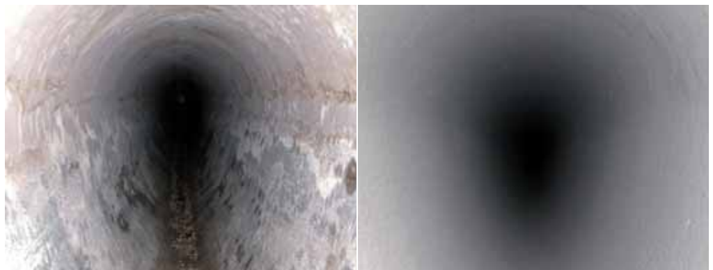
Vorher und nachher: Mineralische Kanalrohrauskleidung im Anschleuderverfahren.
