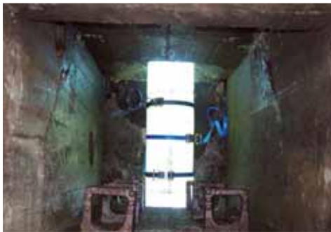
Einzug eines GFK-Liners.
