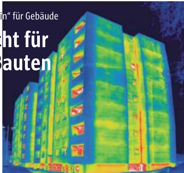
Eine Thermografie deckt mangelhaften Umgang mit Energie bei einem Haus auf.
