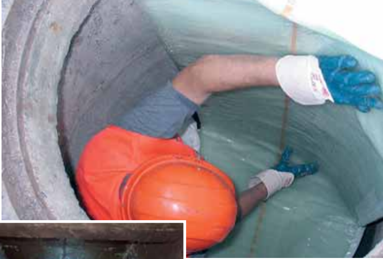
Einzug eines GFK-Liners.
