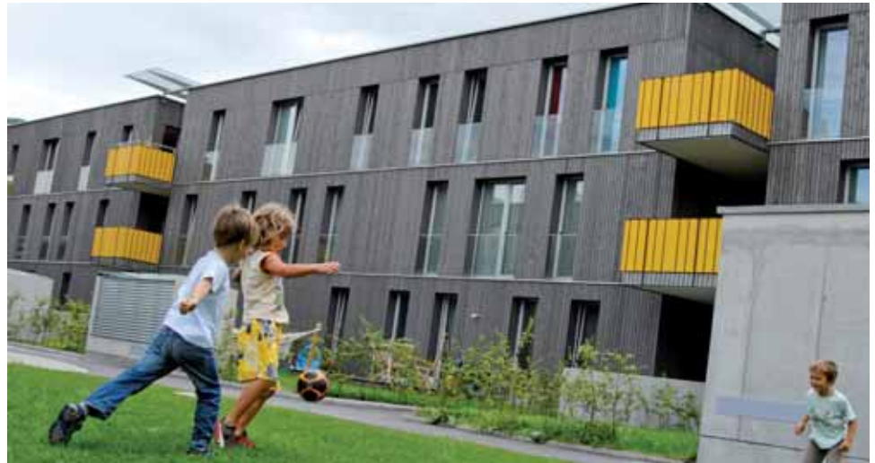
Auch mehrgeschossige Wohnbauten lassen sich aus Holz einfach, rasch und günstig herstellen.
