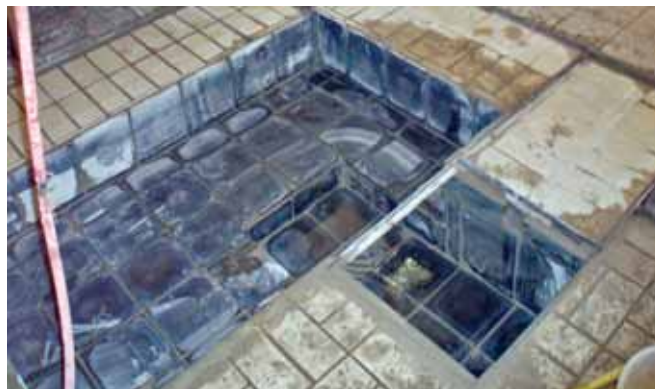
Kürzlich hat die Firma Rabmer, Altenberg bei Linz (OÖ), ca. 35m 2 Becken einer Gerberei in Traun mit einer Schmelzbasalt Auskleidung fertig gestellt.
