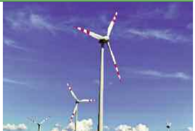
Vier zusätzliche Windräder werden in Pottingbrunn gebaut.
