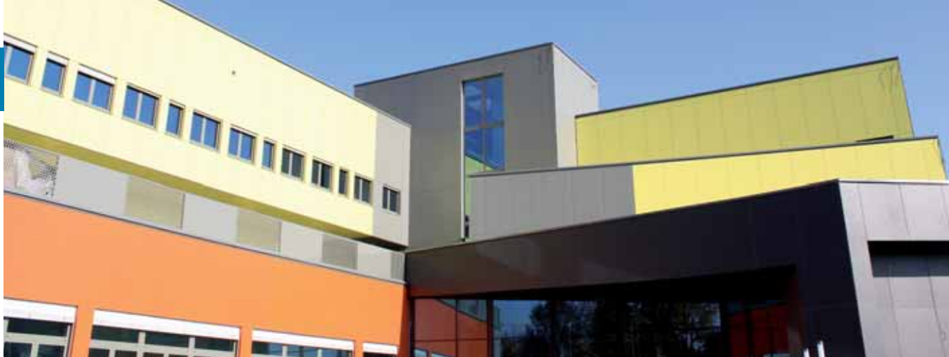
Das neue Veranstaltungszentrum Multiversum in Schwechat.
