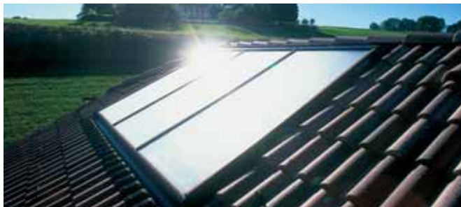
Eine Investition in das Projekt „Neu-Dach“ macht sich in vielen Fällen rasch bezahlt.
