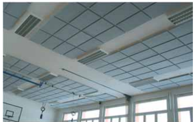
Turnsaal mit verklebten Bastotect ® Absorbern
