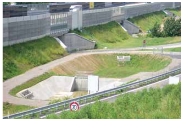
●● Straßenentwässerung durch Versickerung über einen Bodenfilter.
