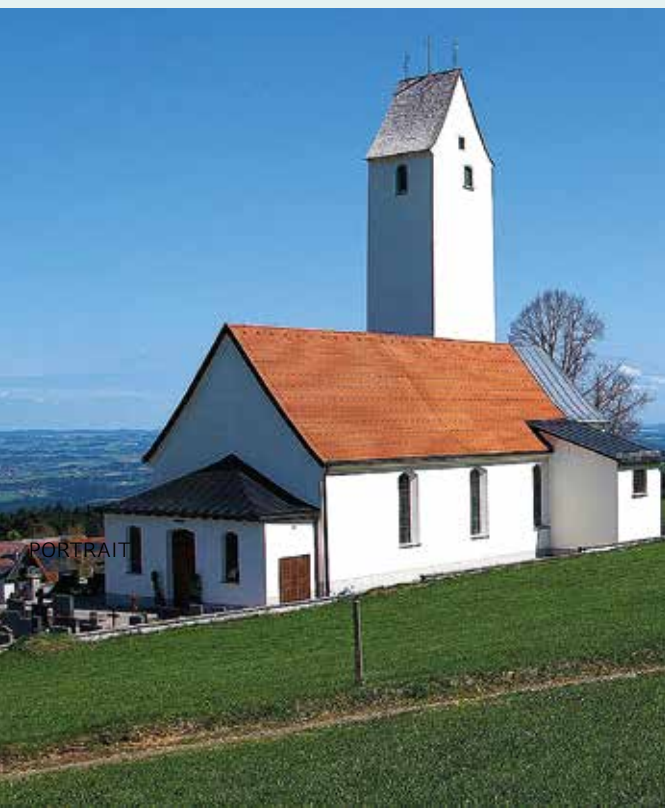
Die römisch-katholische Pfarrkirche ist dem heiligen Ulrich von Augsburg geweiht und steht auf einer Anhöhe im Süden der Gemeinde Möggers.
