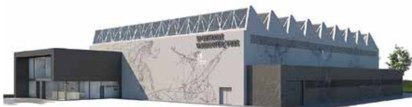
Die im Eigentum der Stadt Waidhofen/Ybbs stehende Sporthalle wird derzeit einer Generalsanierung unterzogen. Umkleidekabinen, Wasch- und Duschräume sowie Halle und Nebenanlagen werden zeitgemäß adaptiert. Baubeginn ist im Juli 2020, Fertigstellung und Übergabe sind für August 2021 geplant.
