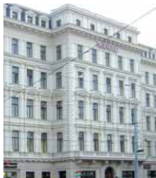
Die Zentrale der ÖVGW am Wiener Schuberting.
