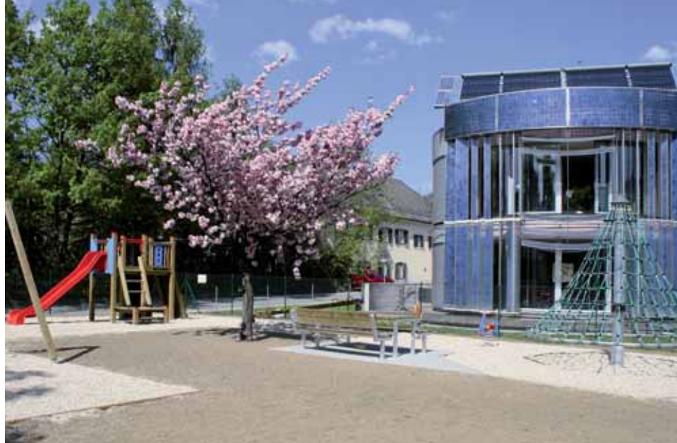
Das Gemini-Haus in Weiz. Ein bewohntes Sonnenkraftwerk, das sich der Sonne nachdreht und daher einen höheren Ertrag liefert.
