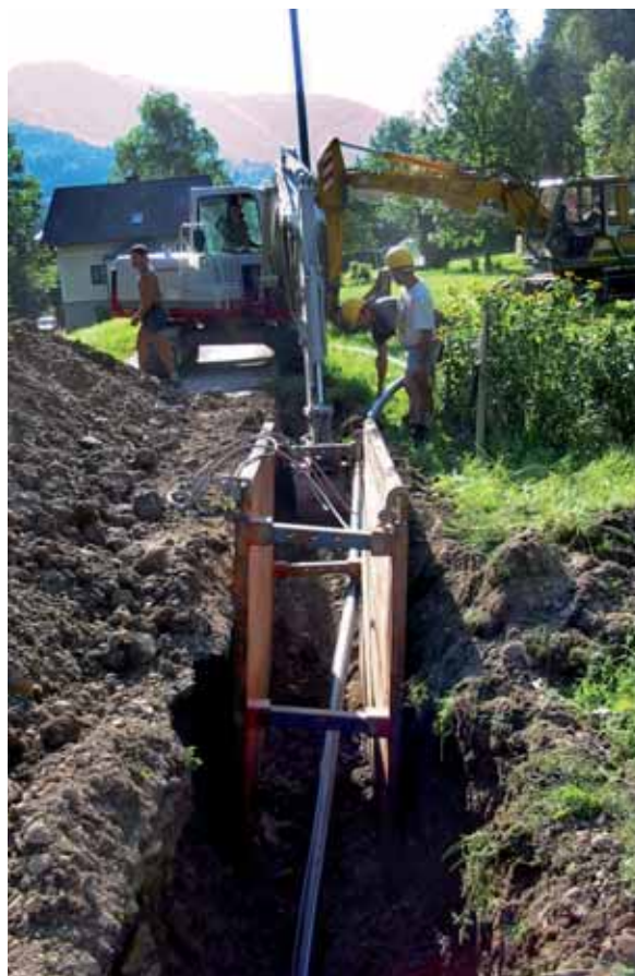
Der Wasserleitungsbau in Dürnbach bei Weyer. Heute gibt es rund 25 Kilometer Wasserleitungsleasing in der Gemeinde.
