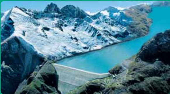
WASSERKRAFT als sauberer Stromlieferant
