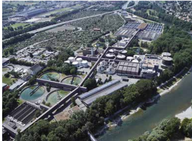
In der größten Kläranlage der Schweiz alarmiert das Personennotsignalgerät SWISSPHONE TRIO, wenn ein Mitarbeiter in Not ist.
