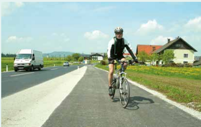
Geh- und Radweg in der Ortschaft Kothgumprechtling.
