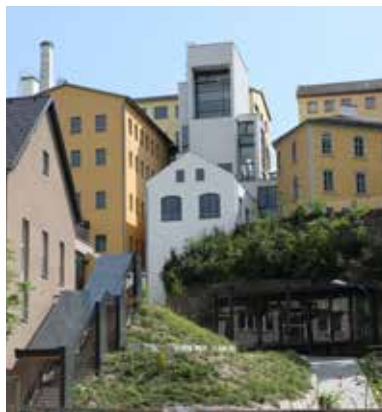
Foto: Vonwiller Areal und Textiles Zentrum in Haslach an der Mühl, Preisträgergemeinde 2009.
